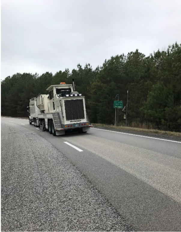
Shotblasting at W4 & W5
