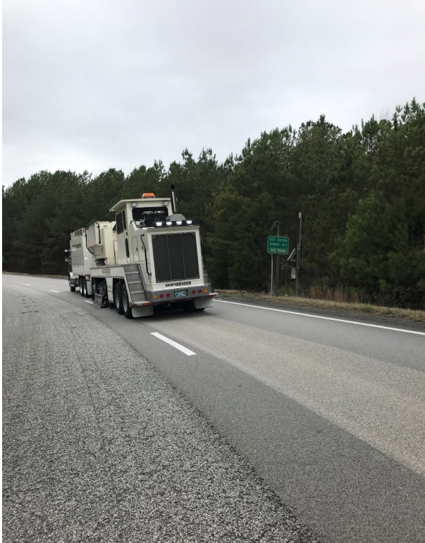
Shotblasting at W4 & W5
